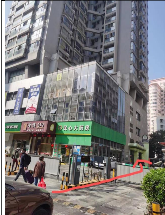
圖一： 深藍公寓停車場入口， 民心大藥房旁邊
